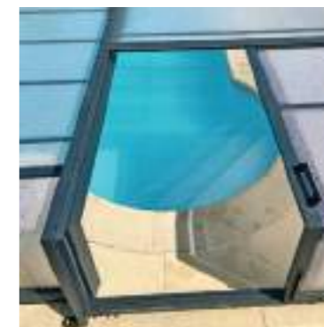
Trappe de toiture latérale
